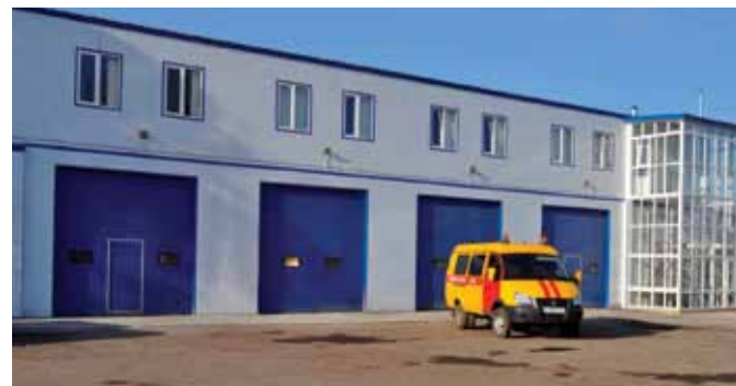
Реконструированное здание производственной базы.
