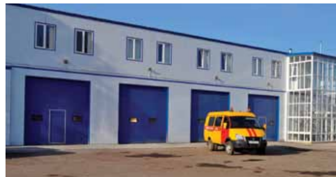
Реконструированное здание производственной базы.
