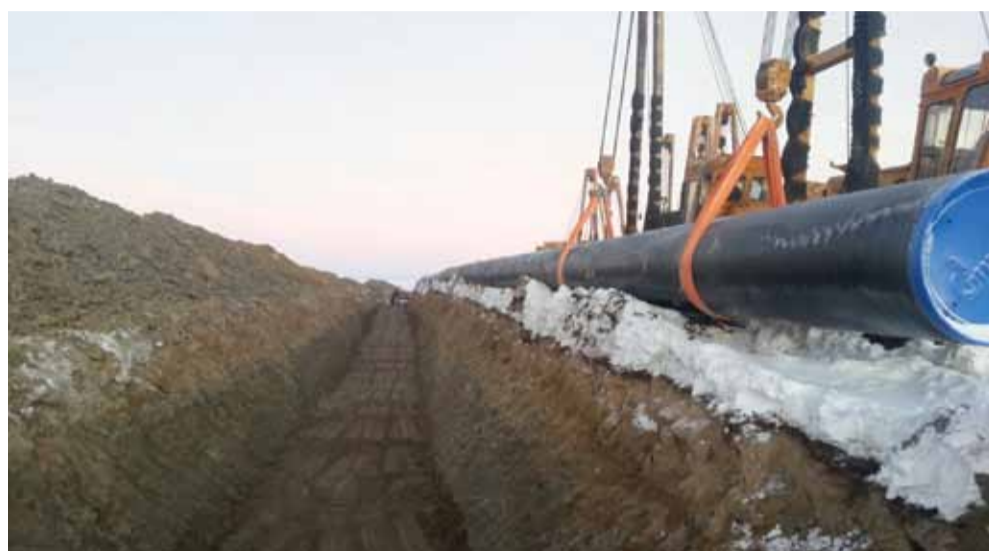
Во время строительства газопровода «Бованенково — Ухта -2».
