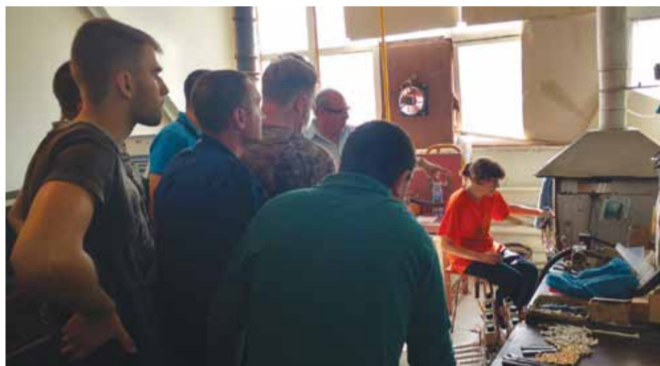
Наладка автоматики газогорелочного устройства.
