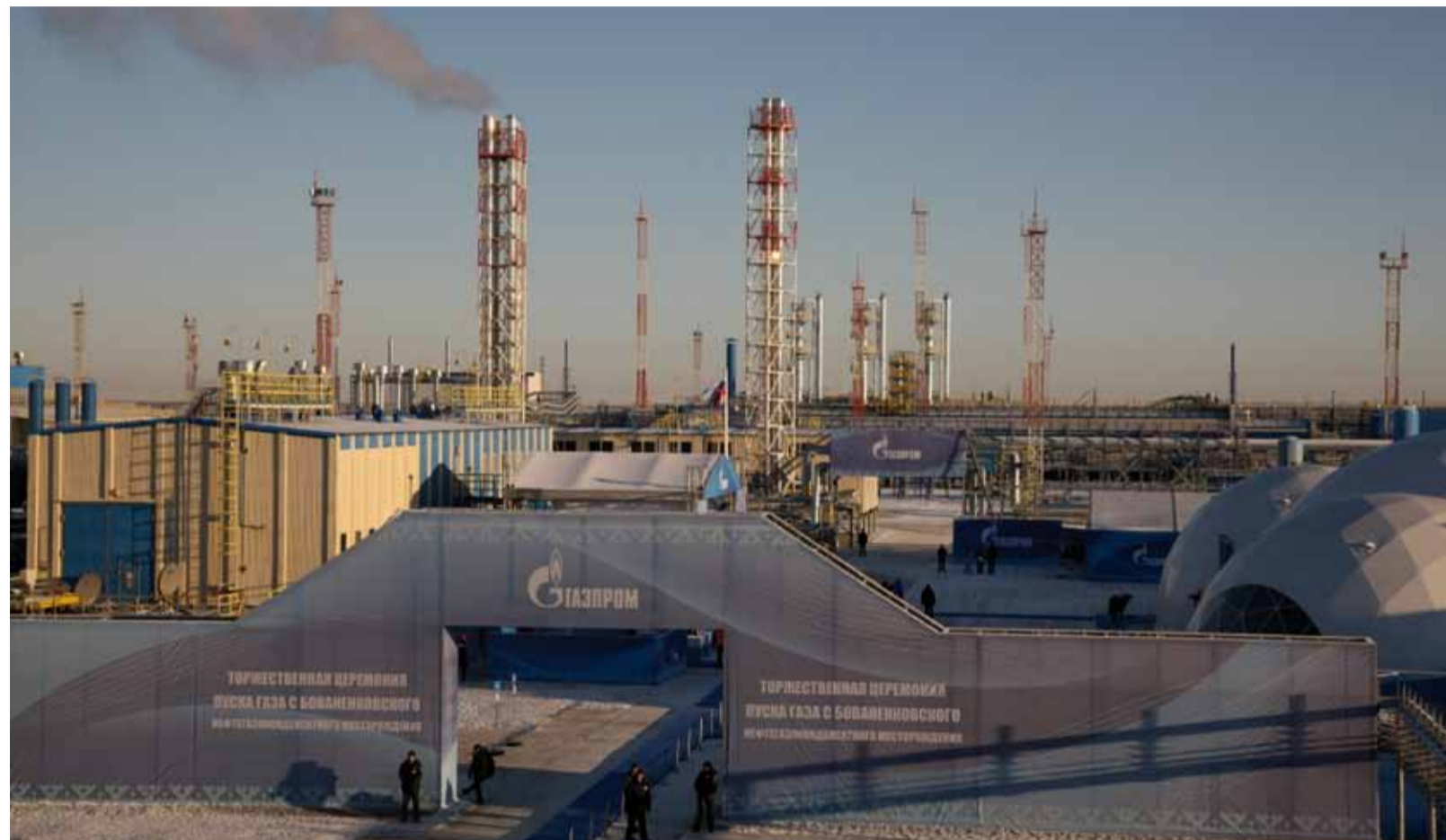
Газовый промысел Бованенковского месторождения.
