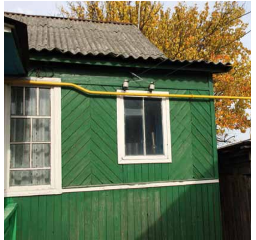
Новый газопровод в домах станичников.
