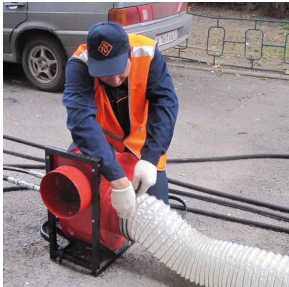
Откачка газо-воздушной смеси универсальной интенсивной вытяжкой.
